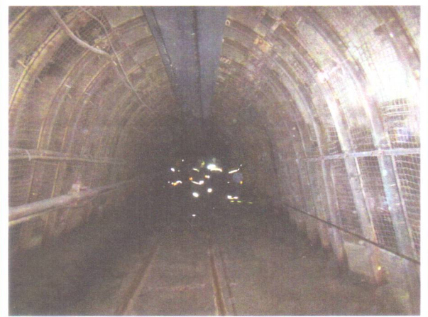
Стійкий стан гірничої виробки з анкерно-рамним кріпленням під час її проведення в зоні високоамплітудних геологічних порушень
